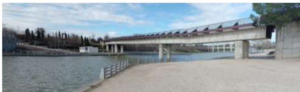
Línea de salida y de meta – Debajo del primer puente
